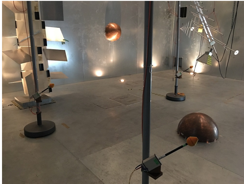
Abbildung 3.39: Kupferhalbkugeln als Diffraktoren an der Wand und auf dem Boden der Modenverwirbelungskammer
